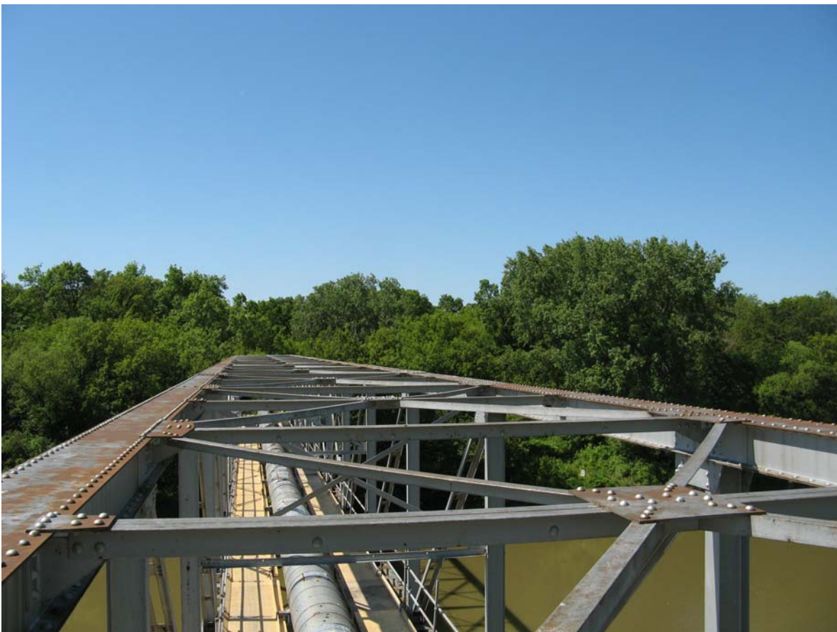
A3-08 - Top of Bridge.JPG
