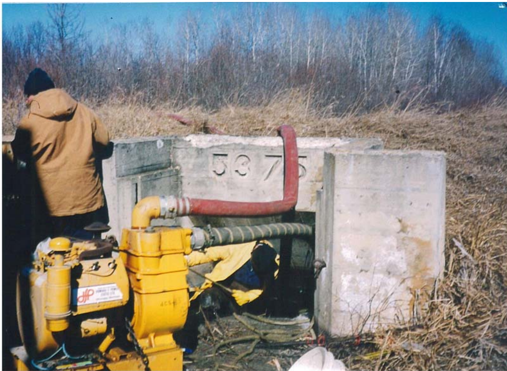
Mile 53.75 Drainage Siphon S. Side Looking N. at S. Headwall
