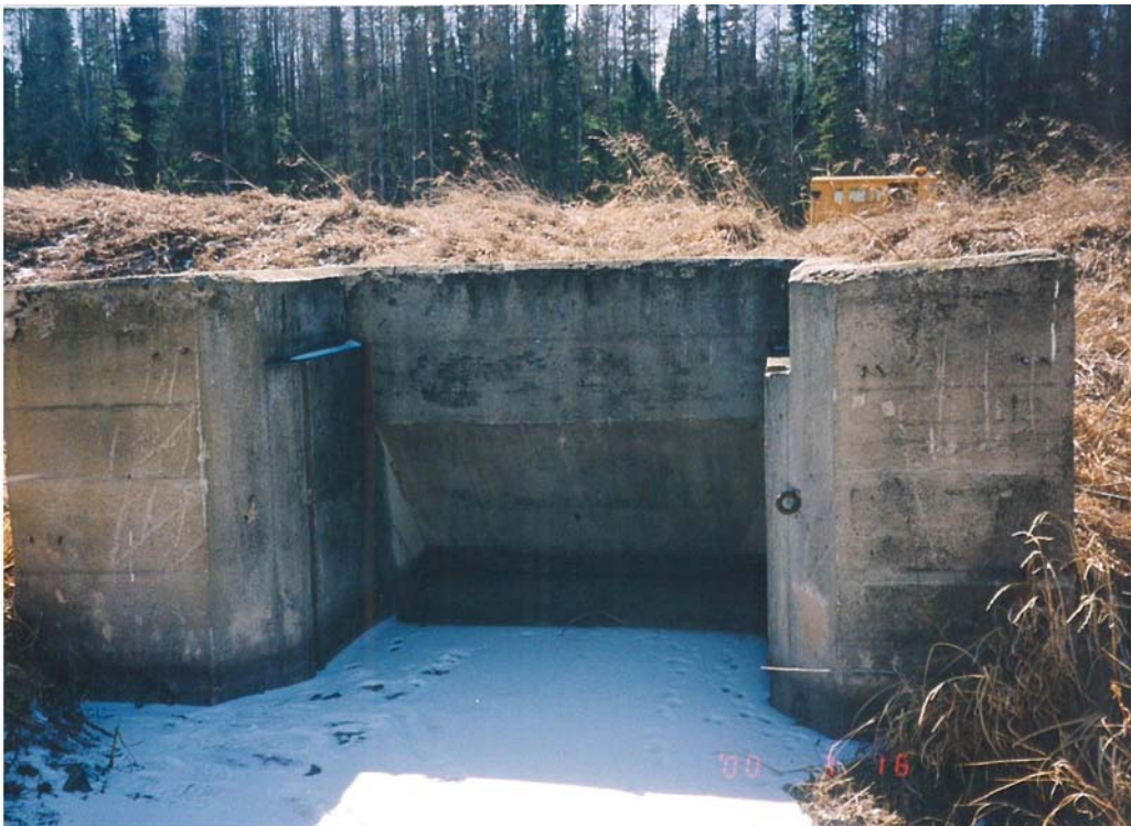
Mile 53.75 Drainage Siphon N. Side Looking S. at N. Headwall
