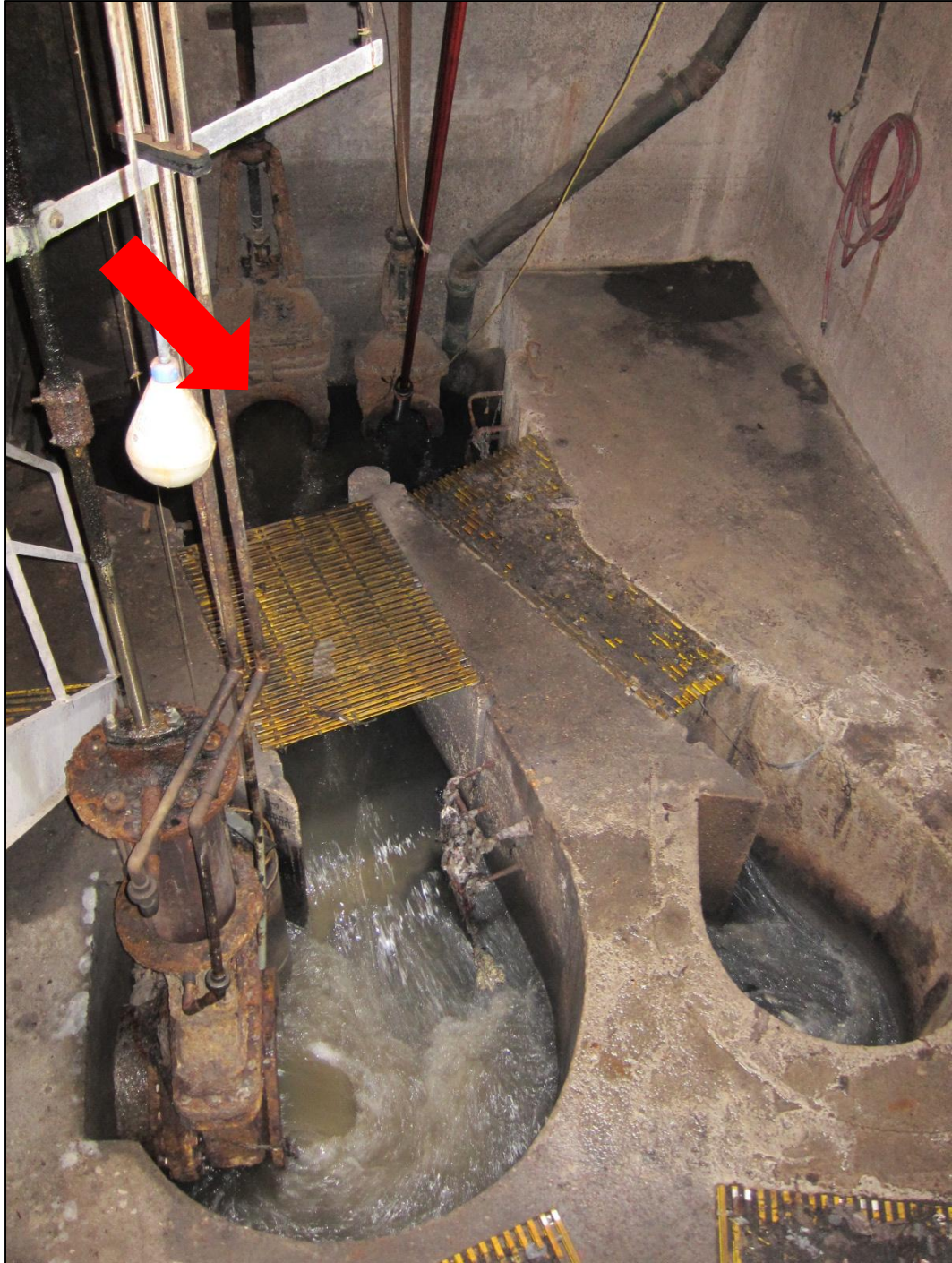
Figure 53 – Bottom sublevel at siphon outlet.
