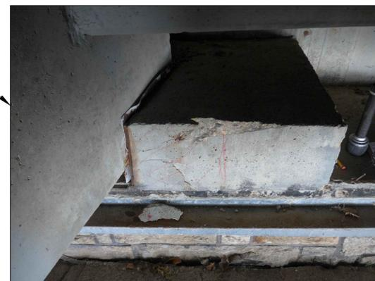
TYPICAL SHEAR BLOCK DELAMINATION
