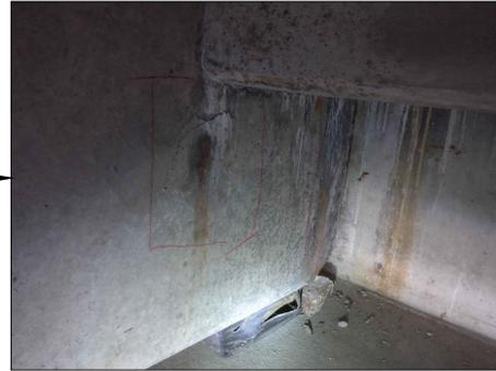
TYPICAL GIRDER SIDE FACE DELAMINATION AND RUST STAINING
