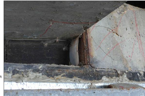
TYPICAL GIRDER SOFFIT AND SHEAR BLOCK DELAMINATION
