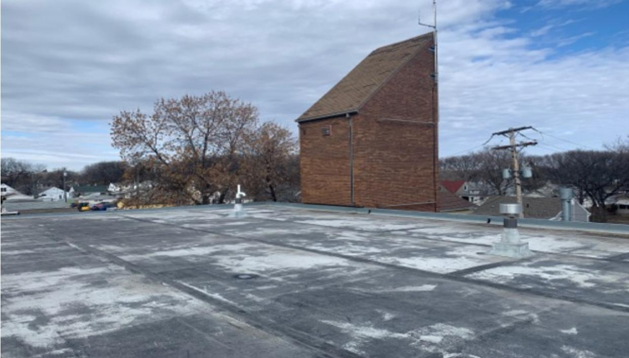
FIG. 3: ROOF-B1 (EPDM) & ROOF-C1 (TOWER) SHINGLES.
