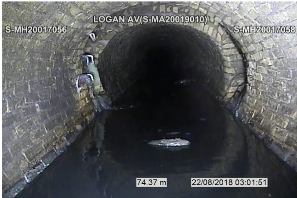
Figure 12 - Site 3: Logan Av S-MA20019010 - General Conditions @ DS Manhole
