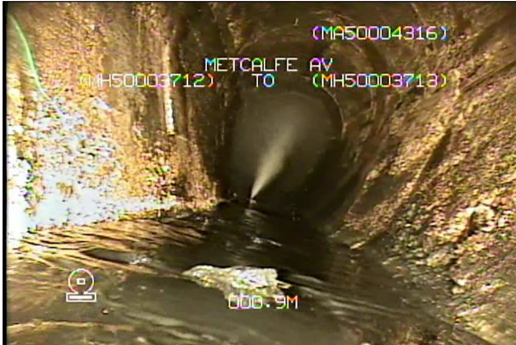
Figure 15 - Site 4: Metcalfe Av S-MA50004316 - General Conditions w/ Surface Spalling
