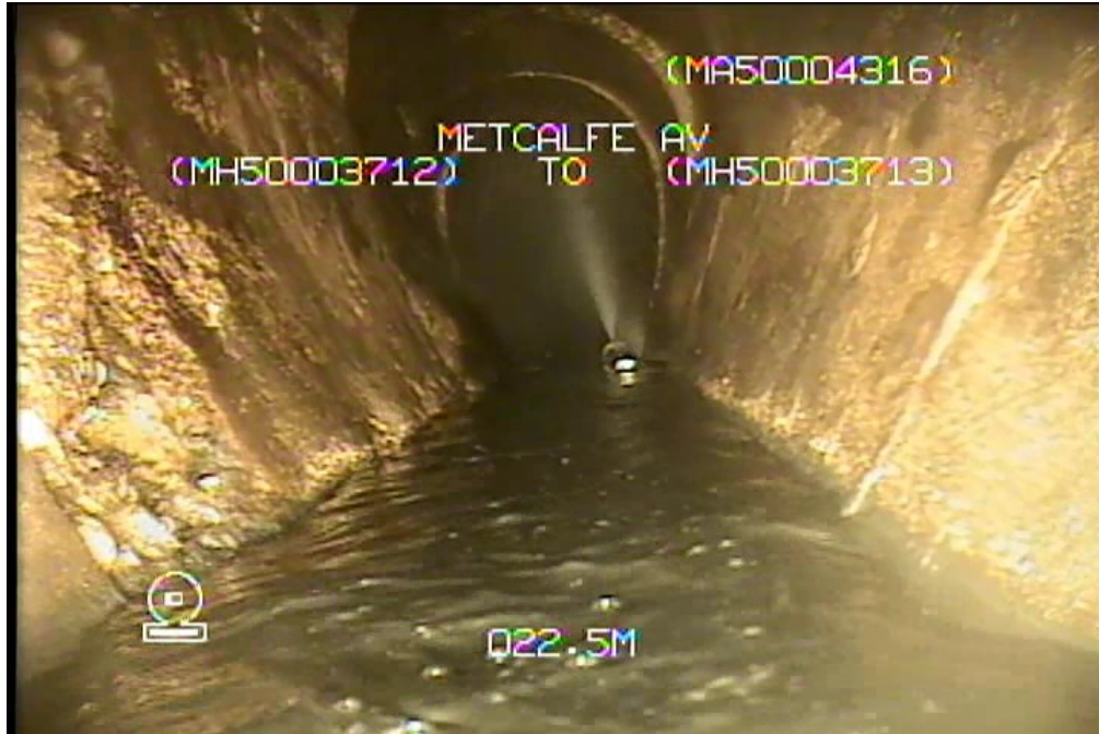
Figure 17 - Site 4: Metcalfe Av S-MA50004316 - General Conditions w/ Surface Spalling
