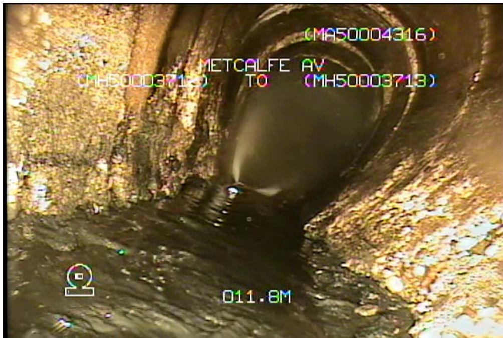
Figure 16 - Site 4: Metcalfe Av S-MA50004316 - General Conditions w/ Surface Spalling
