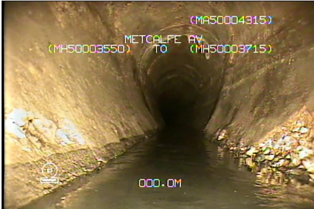
Figure 13 - Site 4: Metcalfe Av S-MA50004315 - General Conditions w/ Surface Spalling
