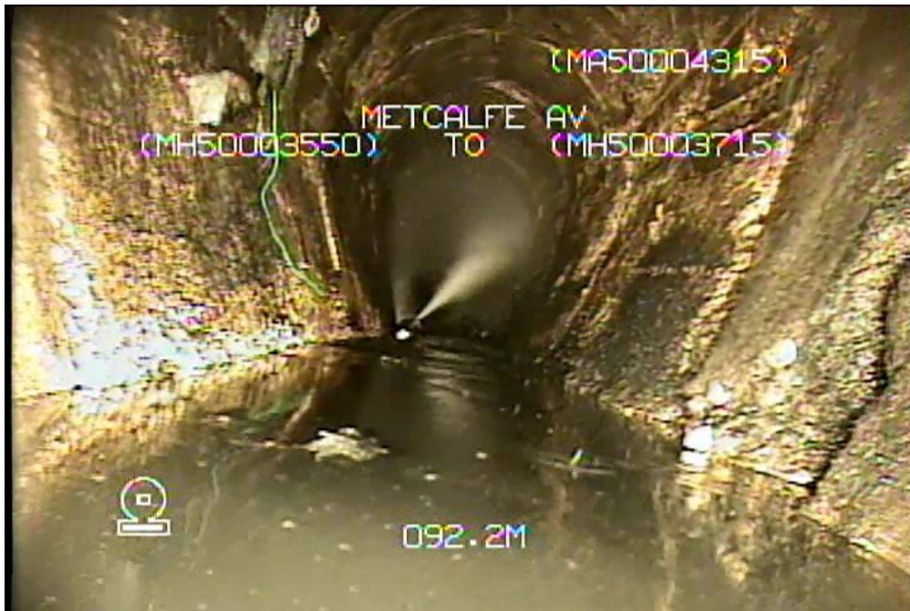
Figure 14 - Site 4: Metcalfe Av S-MA50004315 - General Conditions w/ Surface Spalling
