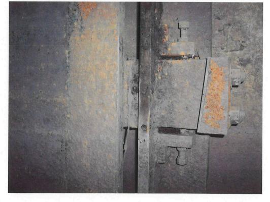
EMBEDDED SLIDE GATE THIMBLE - HEAVY CORROSION
