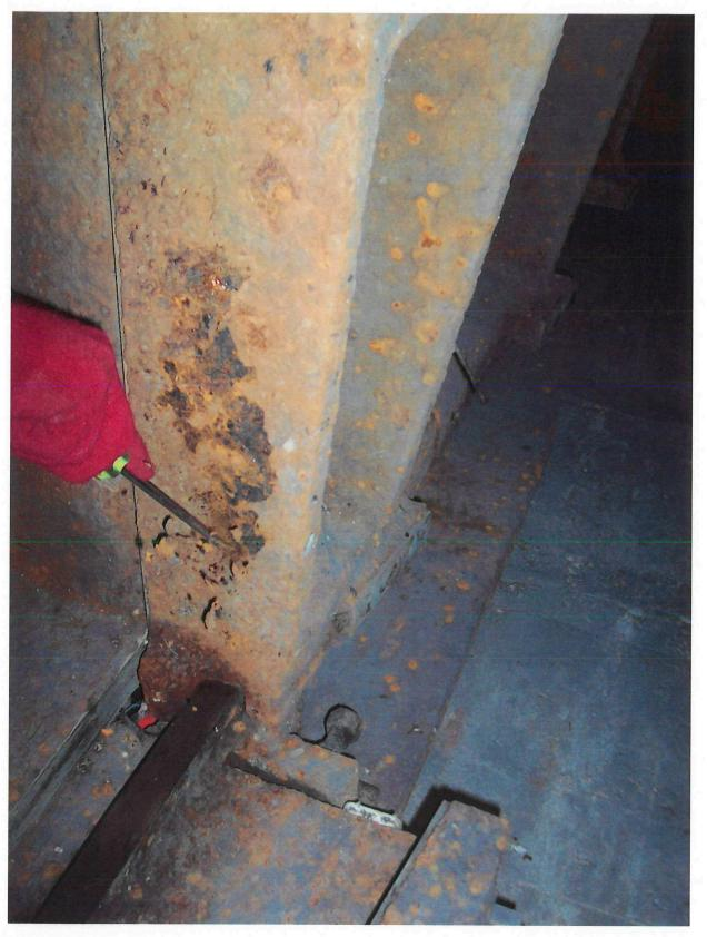
UNDERSIDE OF SLIDE GATE - HEAVY SECTION LOSS
