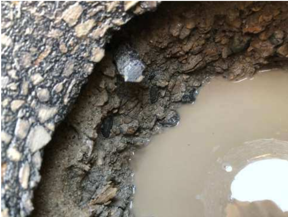
South bound longitudinal joint, Sta. 0+357
