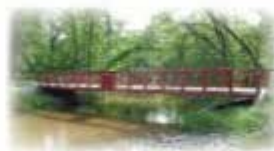
POUTRE EN TREILLIS DE TYPE PRATT (CONFIGURATION EN U)
