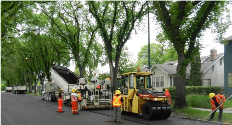
**Thin Bituminous Overlay (TBO) Program**
