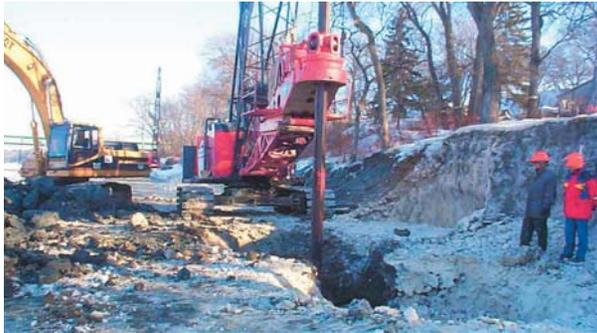
**1** PERÇAGE DES COLONNES D'ENROCHEMENT
