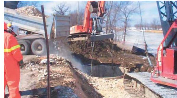
**2** REMPLISSAGE DES COLONNES D'ENROCHEMENT
